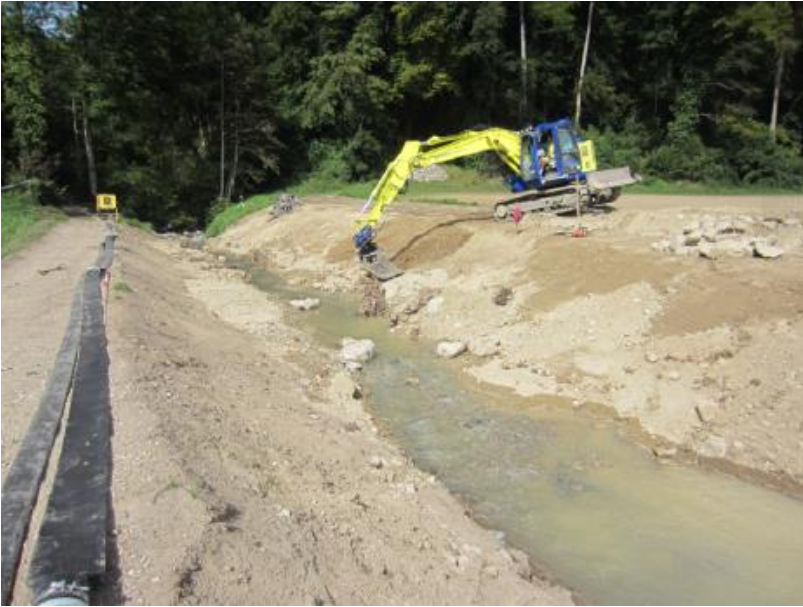
Einbau der Uferfaschinen im Abschnitt Wald-Uferweg (Blick gegen Fließrichtung).
