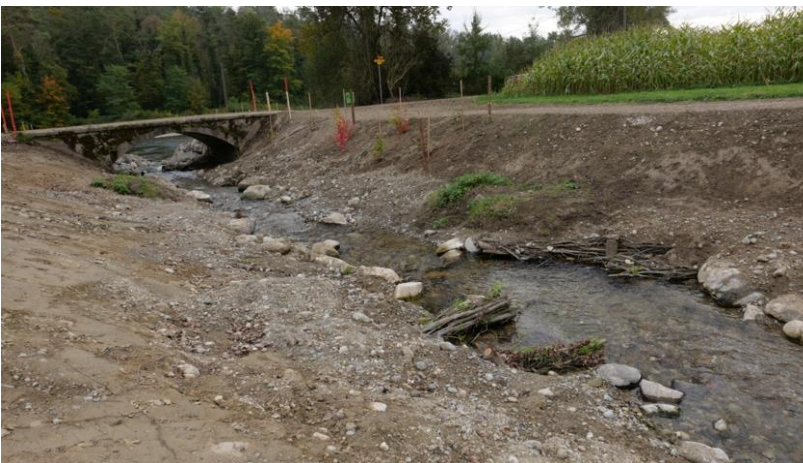
Strukturierung im/am Gerinne bachaufwärts der Uferwegbrücke (Blick in Fließrichtung).
