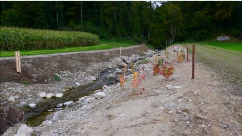
Strukturierung im/am Gerinne im oberen Projektperimeter (Blick gegen Fließrichtung).
